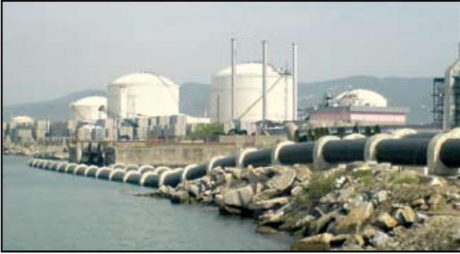
Cada emisario submarino es tratado independientemente puesto que existen variables específicas de localización, diseño y ejecución que repercuten directamente en la elección de las tuberías óptimas para afrontar cada obra particular. Dichas variables son, entre otras, la profundidad de hundimiento, altura de ola representativa, peso de lastrado, cargas de aplastamiento, metodología de hundimiento o presión de servicio en régimen permanente.
