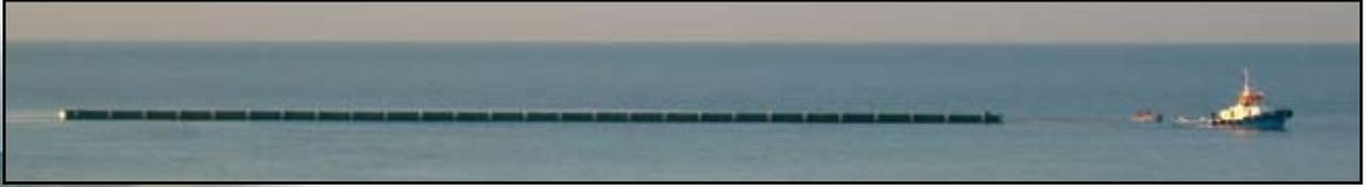
**5** Una vez posicionado el tramo en la zona de hundimiento se procede a la apertura de las válvulas de entrada de agua por un extremo del tramo y de salida de aire por el extremo contrario de forma que se provoca la "S" de hundimiento característica del procedimiento de fondeo controlado por inundación progresiva, característico de tuberías de PEAD.
