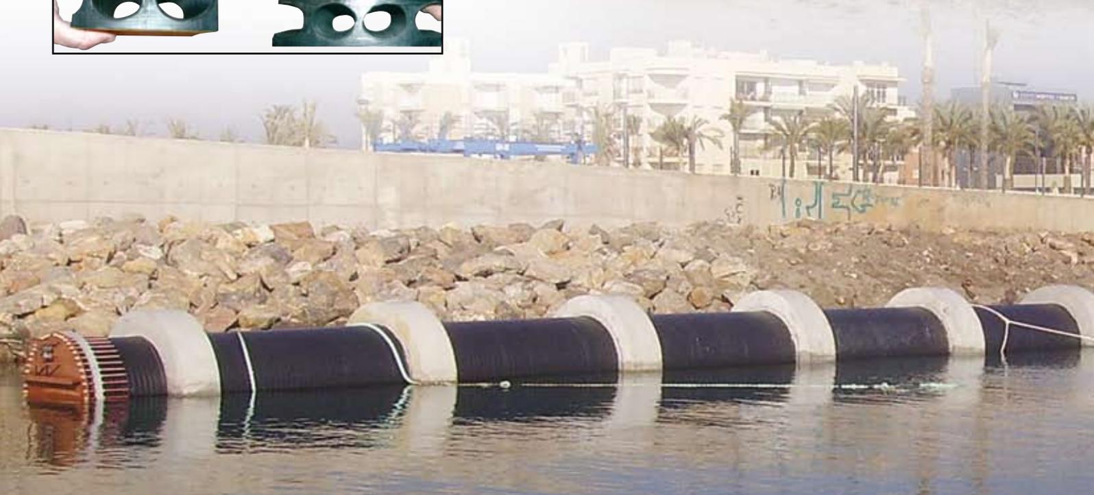
PPA&KRAH está en disposición de suministrar y montar en obra cualquier accesorio necesario para afrontar la realización de un emisario submarino como portabridas, bridas ciegas, pasamuros, curvas, bocas de hombre, carretes especiales de conexión, etc...
