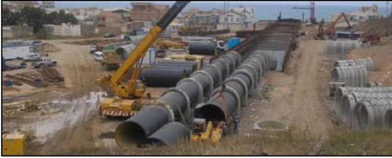
**2** Una vez soldadas las uniones y previamente a la colocación del lastre cada 6 m, se procede al ensayo de cada una de las uniones Electro-Soldadas.
