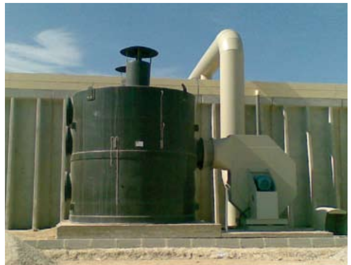
Instalación de Desodorización de Carbón Activo con Torre Vertical Diámetro 3000, Q=20.300 \text{ m}^3/\text{h} .
