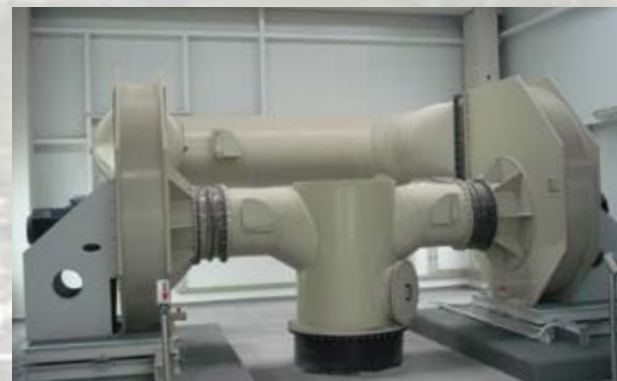
Instalación de Desodorización por Vía Química Q=35.000 \text{ m}^3/\text{h} .
